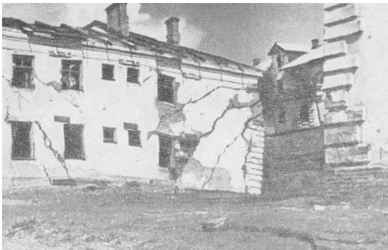
Рисунок 4.20. Разрушение здания в зоне сдвижения пород над горными выработками – подрабатываемой территорией (по Котлов, 1977)
